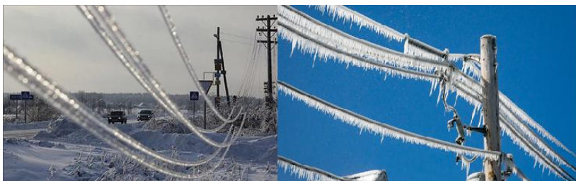
Рис. 1. Образование гололедицы на проводах линий электропередач
